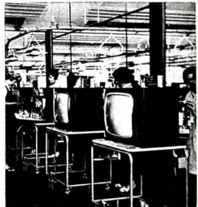
Bild 2. Einbau der Farbfernsehempfänger-Bausteine in die auf fahrbare Tische gestellten Gehäuse
