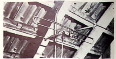
Unterdachbefestigung einer Antenne mit Antennenröhrer „ND 08“ (Wisi)
