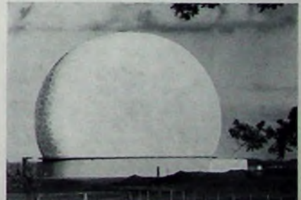
Bild 6. Radom der Erdfunkstelle Raisting
