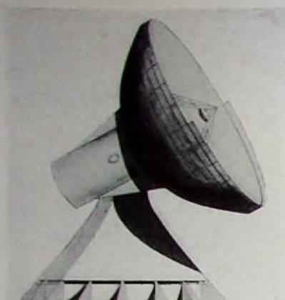
Bild 7. 28,5-m-Cassegrain-Parabolantenne der Erdfunkstelle Raisting II
