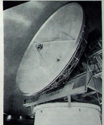
Bild 5. 25-m-Cassegrain-Parabolantenne der Erdfunkstelle Raisting I
