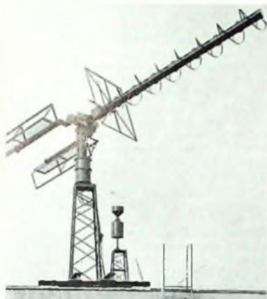
Bild 2 Antennensystem einer Wettersatelliten-Empfangsanlage. Im Hintergrund Funkbeschickungsantenne. Standort: Zentralamt des Deutschen Wetterdienstes, Ollnabach am Main
