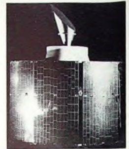
Bild 1. Außenansicht der Intelsat-III-Satelliten (Gewicht 113 kg, 142 cm Ø, 94 cm Höhe, Sendeleistung 2 x 11 W, Antennengewinn 15 dB, Übertragungsbandbreite 2 x 225 MHz, vorgesehene Lebensdauer etwa 5 Jahre)
