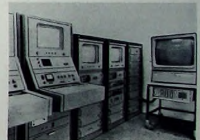
Bild 3. Ausschnitt aus dem Geräteaufbau der Fernsehzentrale des Universitätsklinikums
