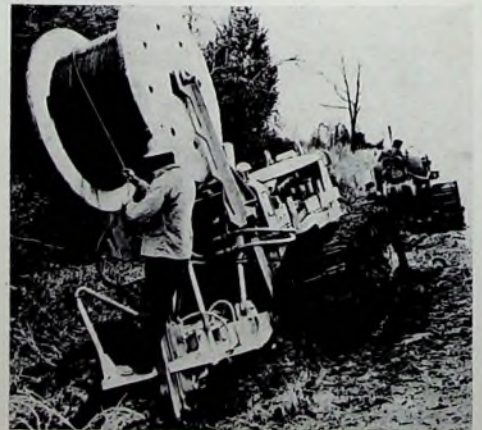
Bild 5. Kabelverlegemaschine im Einsatz
