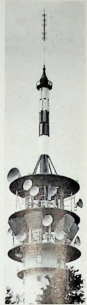
Fernmeldeturm Stuttgart-Frauenkopf mit Richtfunk- und Fernsehantennen
