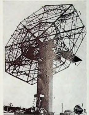
Bild 2. Nachführantenne der Zentralen Deutschen Bodenstation (ZDBS) in Lichtenau bei Weilheim/Obb. Aufnahme: AEG-Telefunken
