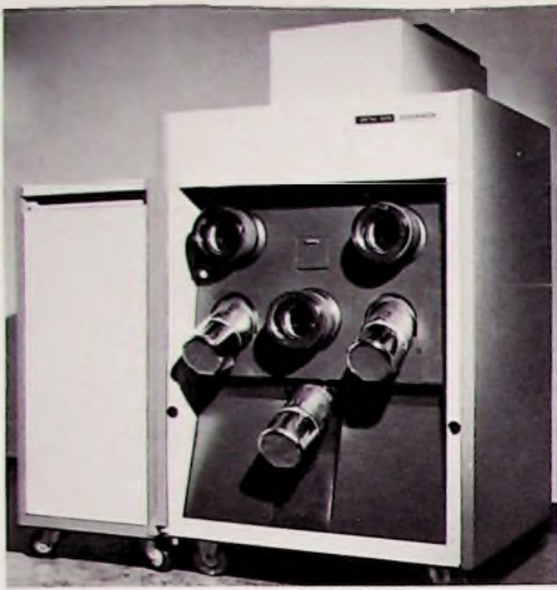
Bild 4 Vorderansicht des Eidophor - Projektors Gretag „5070“
