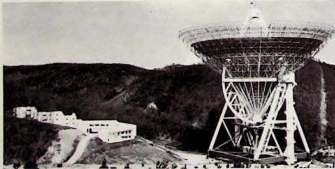
Das neue Radioteleskop mit den Betriebsgebäuden in einem Eifeltal bei Effelsberg. Die Kabine unterhalb der eigentlichen Antenne im Brennpunkt des Spiegels befindet sich bei senkrechter Stellung der Reflektorschale (Reflexions-Paraboloid) 98 m über dem Erdboden. Aufnahme: Krupp
