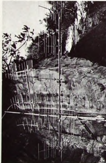
Bild 2. Antennenanlage in der Falätsche
