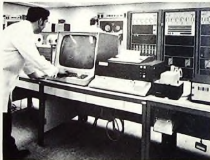
Datenverarbeitungsanlage der Computer-Telex-Auskunft im Rechenzentrum des FTZ
