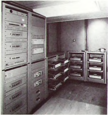
Bild 6. Gestellzentrale mit Verstärkern und Tonbandgeräten
