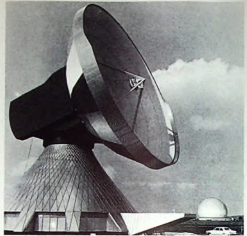
Bild 7. Erdfunkstelle Raisting der Deutschen Bundespost. Im Vordergrund Teilansicht mit der freistehenden Antennenanlage „Raisting II“ (Spiegeldurchmesser 28,5 m), im Hintergrund die unter einem Radom befindliche Antennenanlage „Raisting I“ (Spiegeldurchmesser 25 m, Radomdurchmesser 48,8 m) (Werkfoto Siemens)
