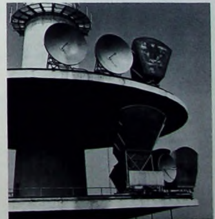
Bild 4. Verschiedene Antennenarten auf den Plattformen eines Fernmeldeturms (Werkfoto SEL)
