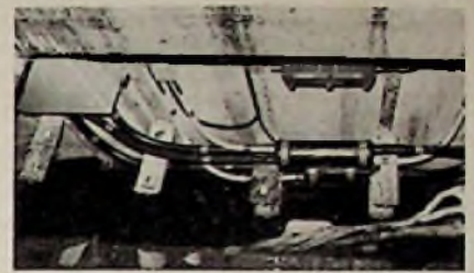
▲ Bild 4 (oben). Verstärker im Kabelschacht
