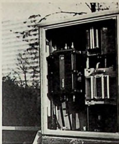
▲ Bild 4 (oben). Verstärker im Kabelschacht
