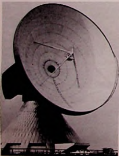
Bild 3. Eine Parabolspiegelantenne der Erdfunkstelle Raisting mit etwa 30 m Durchmesser und 30 m Höhe verbindet über Intelsat III das Fernsprechnetz der BRD mit dem asiatischen Netz. (Foto: AEG-Telefunken)
