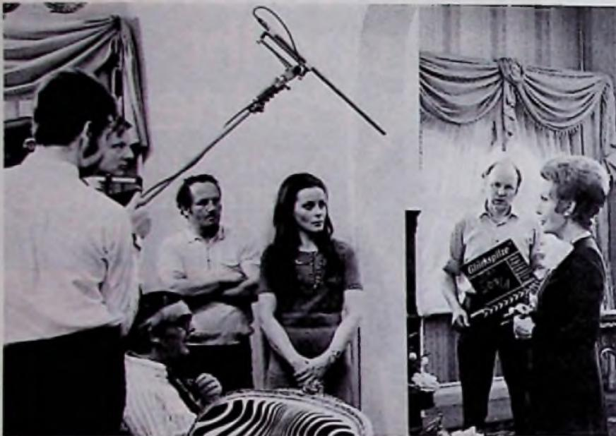
Filmtonaufnahme mit einem Richtmikrofon an der Angel. Links im Vordergrund der Tonassistent, der die Angel hält.
