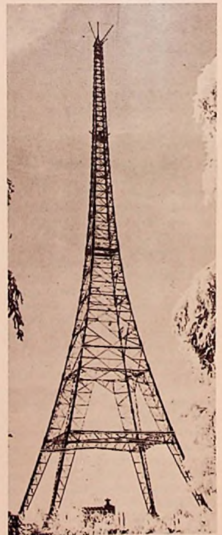
Bild 1. Holzturm des Mittelwellensenders München-Ismaning im Jahr 1950
