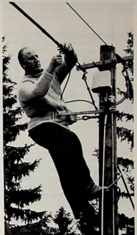
Montage des Lichtleiter-Kabels am Mast
