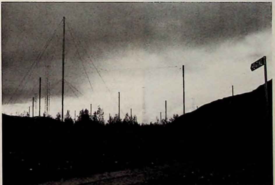
Bild 1. Kreuzdipole des Antennenwalds für die „Heating“-Sendeanlage im Ramfjordmoen-Tal bei Tromsø
