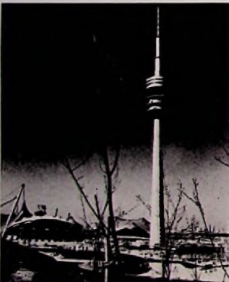
Bild 1. Olympia-Turm in München, in dem die rechnergestützte Fernwirkzentrale untergebracht ist
