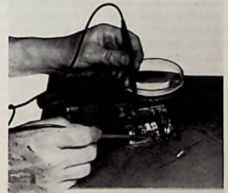
Beim Ansetzen der Prüfspitzen rutscht die Elektronikschaltung nicht weg. Eine sichere Kontaktgabe ist durch den möglichen hohen Anpressdruck gegeben. (Spirig)
