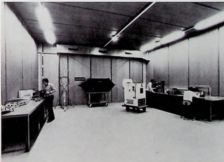
Bild 1: Blick in die neue Störmeßkammer (Schaffner-Pressebild)
