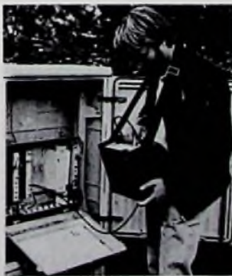
Bild 1: Handlicher Präzisionsmesser für TV-Pilotpegel in BK-Anlagen
