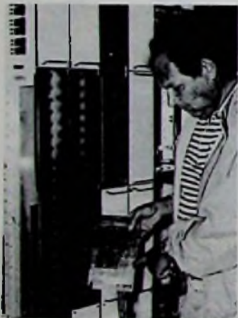
Bild 1: Spleißaufnahme mit 10 Spleißern des Glasfaserkabels für die Fernstrecke (PKI/F & G-Pressbild)
