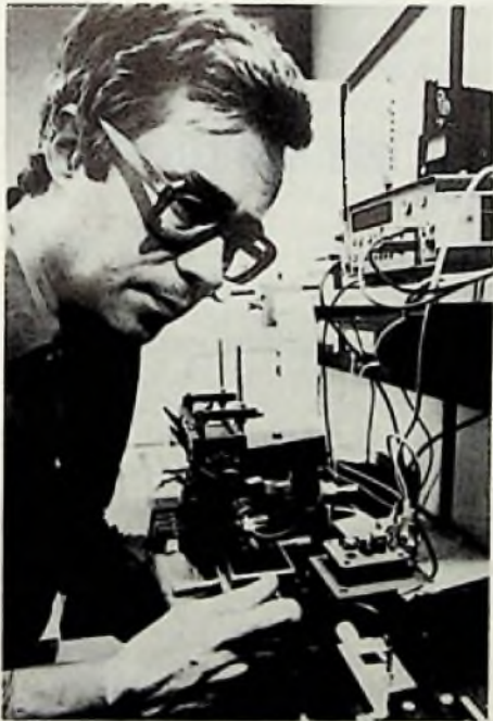
Bild 2: Versuchsaufbau mit dem elektrooptischen Modulator aus Lithiumniobat (Siemens-Pressbild)
