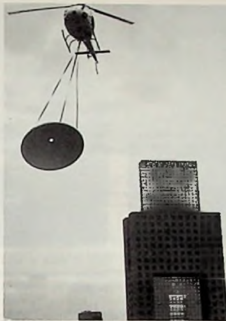
Bild 2: Für Satellitenempfang wurde auf der Halle 9 eine Empfangsanlage installiert – mit einem Helikopter geht das am einfachsten (Foto: Messe Frankfurt)
