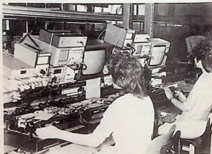
Bild 1: Prüfplatz für die Erstinbetriebnahme der Videorecorder
