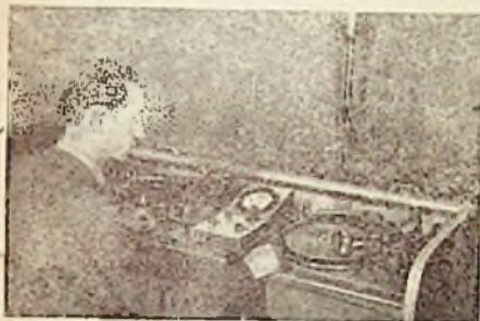
Abb. 1 und 2. Das im oberbayerischen Stil eingerichtete Tonstudio der Firma Wulon-Werke, München-Aubing. Der Schreibtisch im Bild rechts enthält die gesamte Aufnahmeapparat. Das Bild links zeigt die Aufnahme- und Wiedergabeeinrichtung. Die Plattenteller können so aufeinander geschaltet werden, daß man sehr einfach Platten kopieren kann. Jede so hergestellte Schallplatte stellt somit ein Original dar. Verkaufnahmen 4
