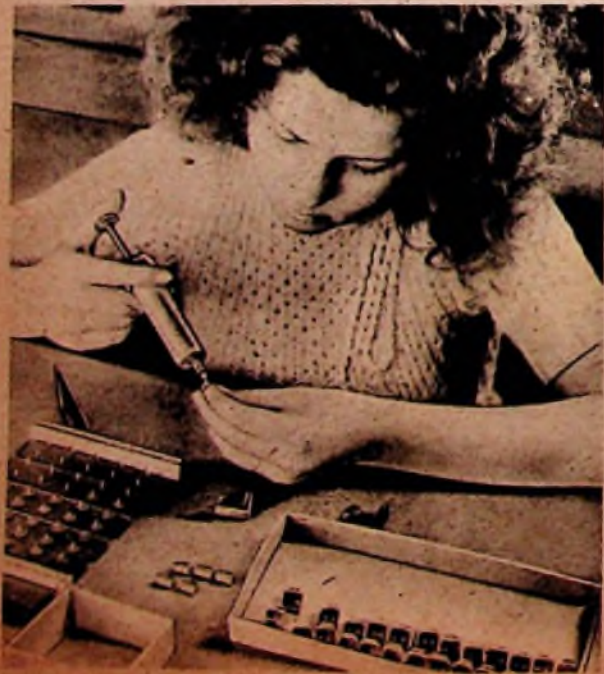
Die Spulenden werden zur Erzielung einer elastischen Verbindung in feinen Spiralen aufgewickelt
