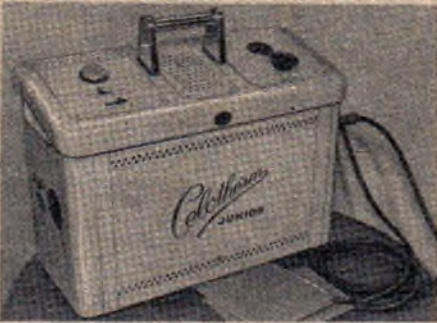
Celotherm-Junior, ein tragbares Röhren-Therapiegerät für UKW-Behandlung der Firma Lorenz AG
