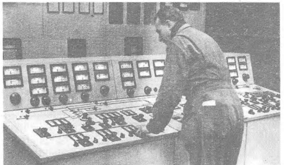
Rechts: In der Wärme-warte. Die Überwachung und die Fernsteuerung der Bensonkessel erfolgt zentral und ist leicht durchführbar
