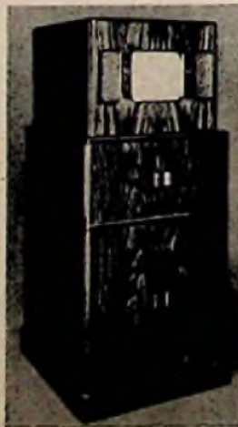
180-Zeilen-Empfänger mit Braunschwer Röhre, Bildgröße 24x30 cm
