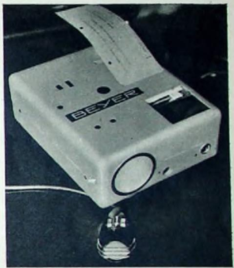
Das Diktiergerät der Firma Beyer verwendet eine blattförmige, leicht ablegbare Folie als Tonträger
