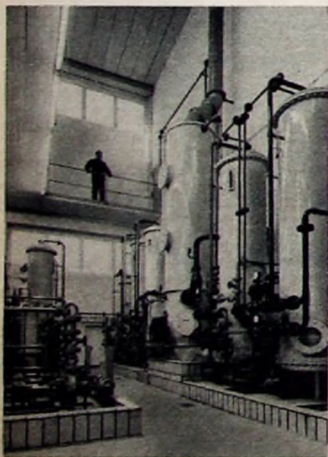
Wasseraufbereitungsanlage für die Deionisierung und Vollentsalzung
