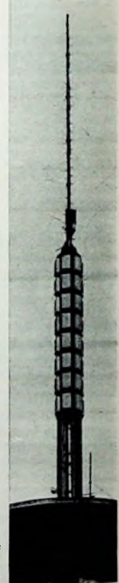
Bild 6. Achterfeld mit \lambda/8 -Trimmer für UHF-Sendern (Telefunken)
