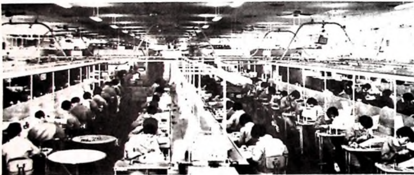
Alle Einzelteile von NATIONAL-Geräten werden in eigenen Werken hergestellt. Unser Bild zeigt einen Ausschnitt der modernen Fertigungsstraßen für den Zusammenbau von Transistor-Radios
