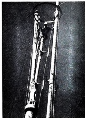
Bild 2 (links) und Bild 3 (oben). Die Bilder zeigen den schwierigsten Teil der Montagearbeiten: das Aufsetzen der etwa 20 m langen letzten Stufe (Bereich-II-Antenne mit aufgesetzter obL-Antenne) auf das bereits bestehende rund 30 m hohe Turmstück. Dazu wurde der schon stehende Teil des Sendeturmes mit zwei Holzmasten verlängert. An einem der Masten wurde eine Rolle angebracht, über die dann eine Motorwinde die oberste Stufe hinaulziehen konnte. Aufnahmen: Mondo Annoni, Luzern
