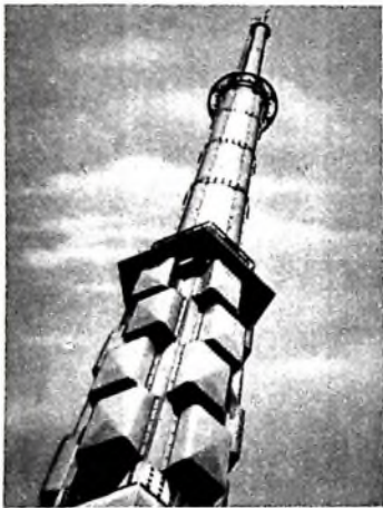
Bild 1. Die Polyesterhauben der Ber-Felder der Bereich-IV-Antenne sind gut zu erkennen
