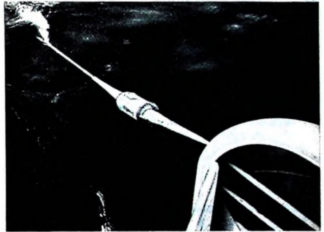
ICECAN Verstärker während der Legung
