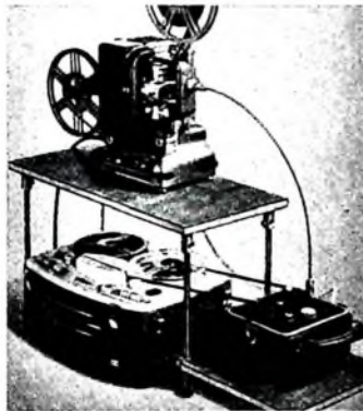
Bild 1. Aufbau zur Filmsynchronisation mit dem Bolex „Synchronizer“
