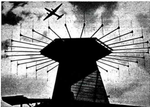
Bild 12. Versuchsanlage eines Dopplerpeilers auf dem Flughafen Stuttgart-Echterdingen
