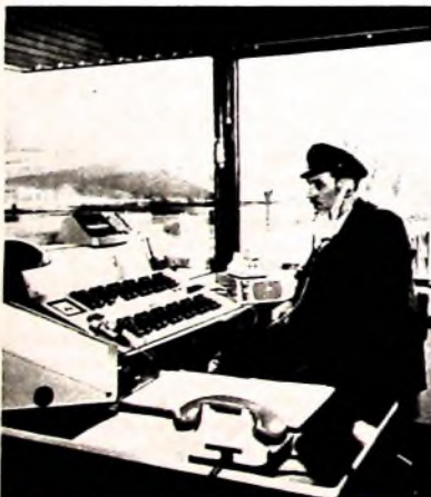
Bild 1. Leitstand des UKW-Funkleit-systems in Hamburg-Wandsbek
