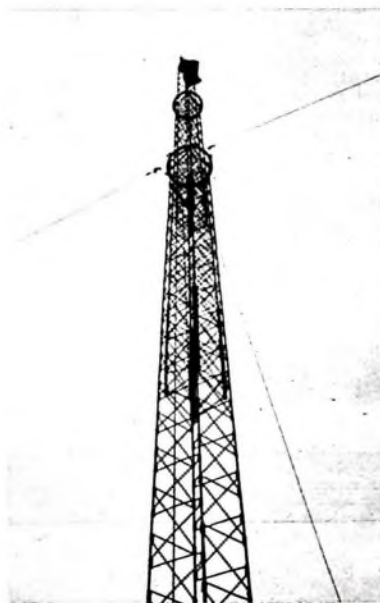
18-m-Stahlgitter-Kurbelmast für Fieldday und Contest
