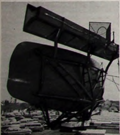
Bild 1. Primär- und Sekundärradarantenne, übereinander auf dem gleichen Drehgestell montiert
