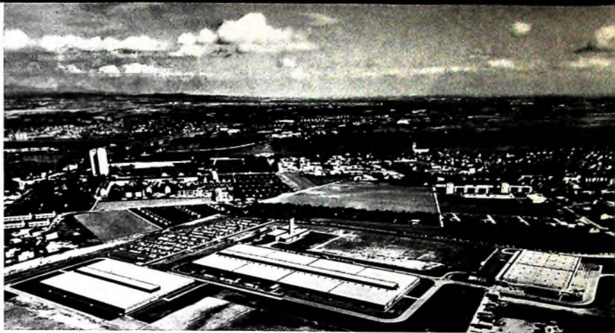
An die bereits im Oktober 1966 in Betrieb genommene erste Baustufe des IBM-Werks Mainz mit 22 000 m 2 Fläche (Mitte) schloß sich jetzt außer der eigenen Energiezentrale und der Versandhalle (rechts) noch eine weitere Baustufe (im Vordergrund links) mit 12 000 m 2 Fläche an.
