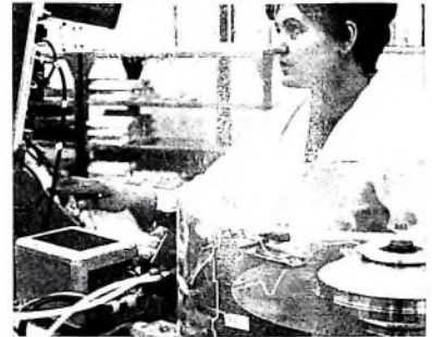
Probelauf eines Schreib-Lese-Magnetkopfes
