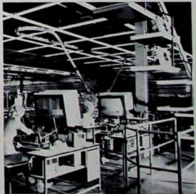
Die Farbfernsehchassis werden im Prüffeld über eine spezielle Fördereinrichtung angeliefert und nach Abschluß der Prüf- und Einstellarbeiten auf dieselbe Weise zum Einbau weiterbefördert.
