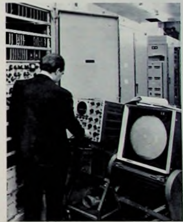
Einer der 400 Gestellschränke der elektronischen Ausrüstung der „Mediator“-Luftverkehrskontrolle
