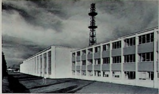
Südansicht des Londoner Luftverkehrszentrums in West Drayton
