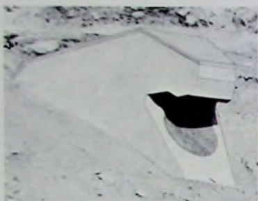
Bild 1 Mikrowellenantenne für Richtfunkstrecken. Sie soll selbst im Feuerball einer Atombombendetonation keinen Schaden erleiden. Der Antennenspiegel hat einen Durchmesser von 1,5 m
