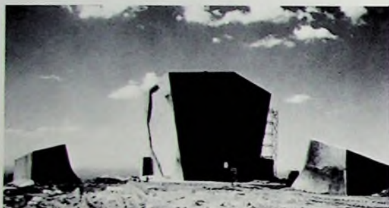
Bild 2 Katastrophensichere Antennen für troposphärische Streustrahlverbindungen. Den Spiegeln mit über 9 m Durchmesser stehen die in Betonblöcke eingebetteten Speisehörner gegenüber
