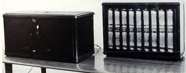
Bild 3 Vierröhren-Zweikreis-Geradeempfänger „40 W“ von Telefunken mit dem Großflächen-Lautsprecher „Arcophon 3“ (Baujahr 1929)
