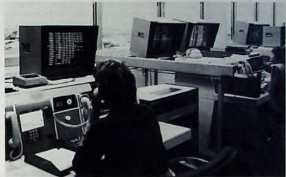
Fernseh-Informationsanlage im Einsatz bei der Stationsleitung
