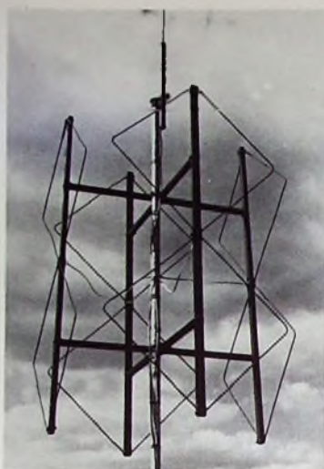
Bild 5 Die Doppelquad-Rundstrahlantenne in Kombination mit einer Sperrtopfantenne.
