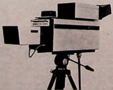
Farbfernsehkamera „FP-1212“ von Hitachi mit 1“-Plumbicon-Aufnahmeröhren
