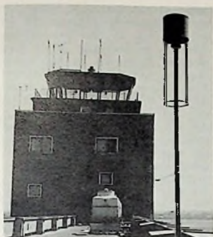
Bild 3. Aktive Antenne für 100 bis 156 MHz
